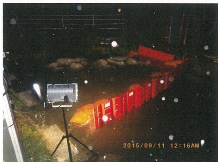
合流下水道人孔の角蓋より溢水した雑排水を左側のグレーチングに導く。
