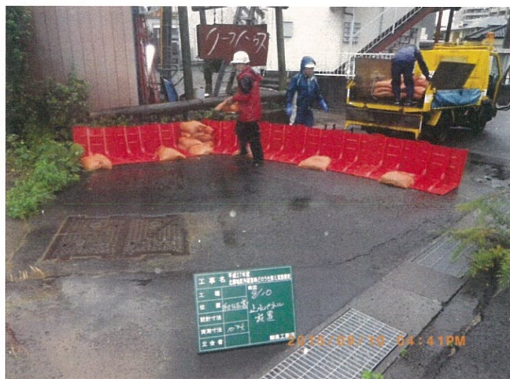
BOXWALL10枚使用。一人で10枚を組み立てても10分とかからない。
